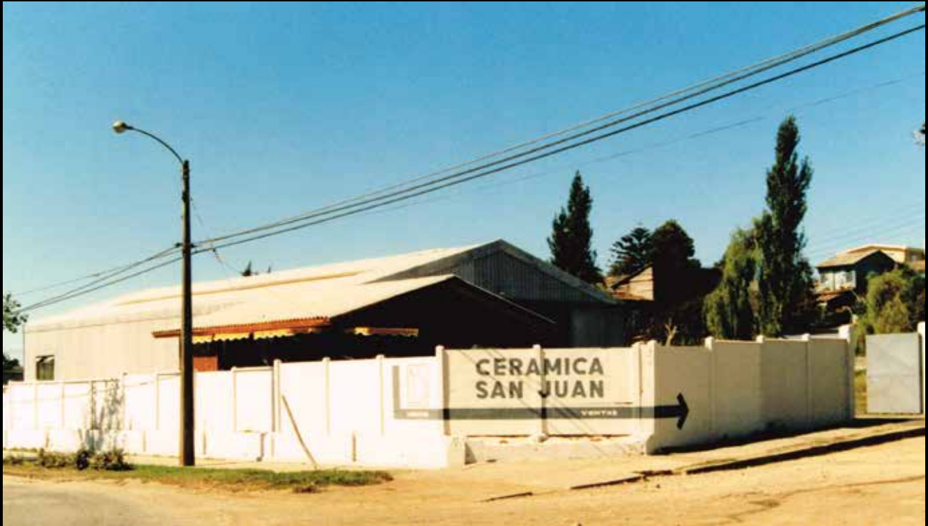
Cerámica San Juan en 1988, emplazada en la intersección de las calles Talcahuano y B. O'Higgins.
